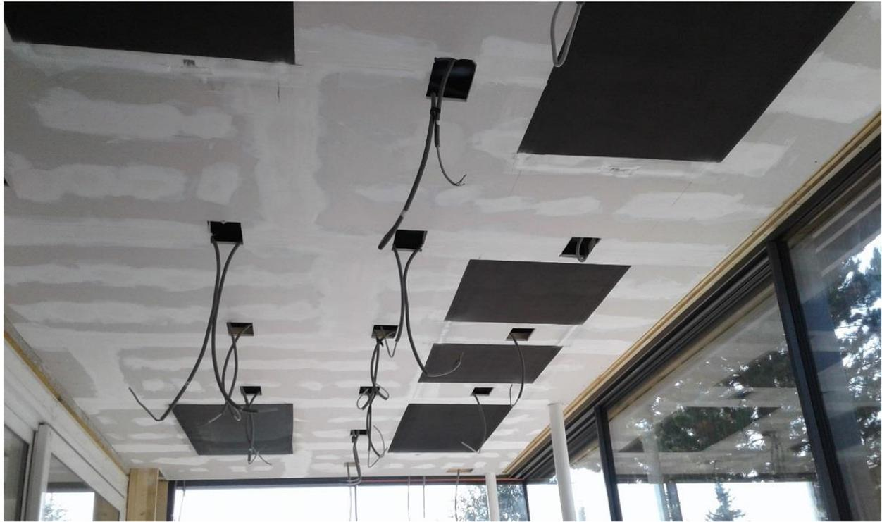
24 Volt Niederspannung - Heizanstrich flächenbündig integriert im
